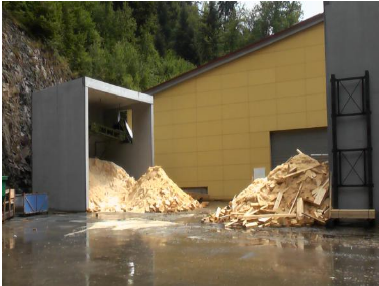
Abbildung 7: Betonsilos mit Aurum- Energie 2018
